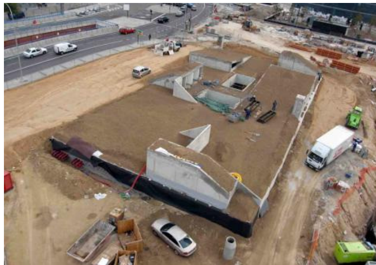
Fig. 14 –ST Deportiva (en construcción)
