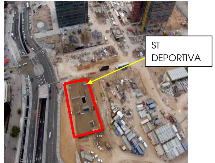
Fig. 13 – ST Deportiva (en construcción)
