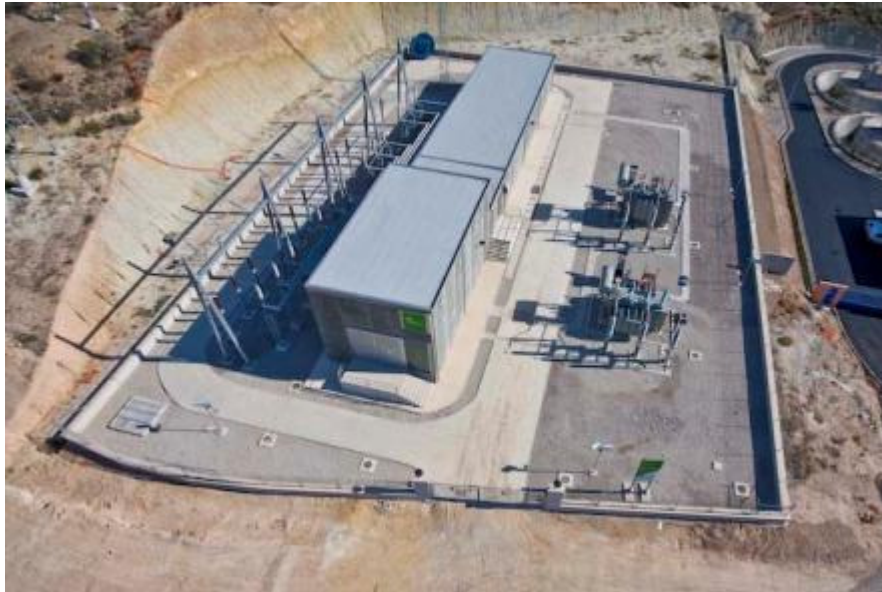
Fig. 5 – Fotografía aérea ST Condomina
