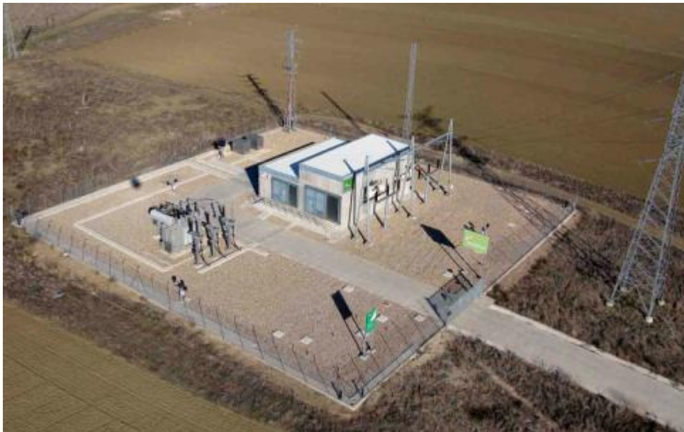
Fig. 4– Fotografía aérea ST Villaluenga de la Sagra
